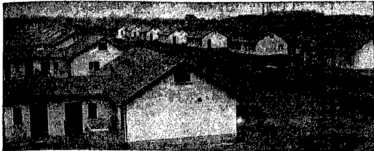
Stadtlandsiedlung in Brandenburg an der Havel. Erwerbslose und Kurzarbeiter sind mit Unterstützung der Stadt vor deren Toren angesiedelt worden. Die Siedler leisteten einen erheblichen Teil der Bauarbeit. —
