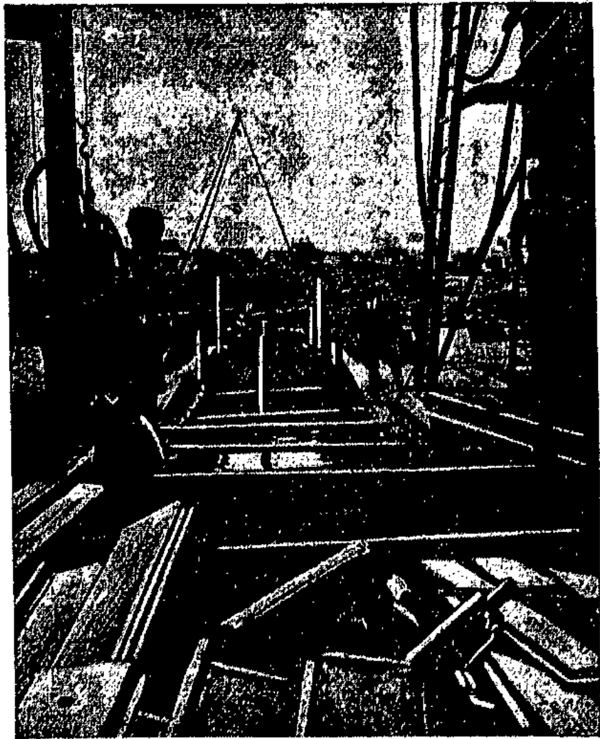
Blick in den Graben, der die Wasserrohre aufnehmen und unter die Ohre hindurchführen soll. Im Hintergrund quer das hölzerne Ueberleitungsbett des Mähdens.
