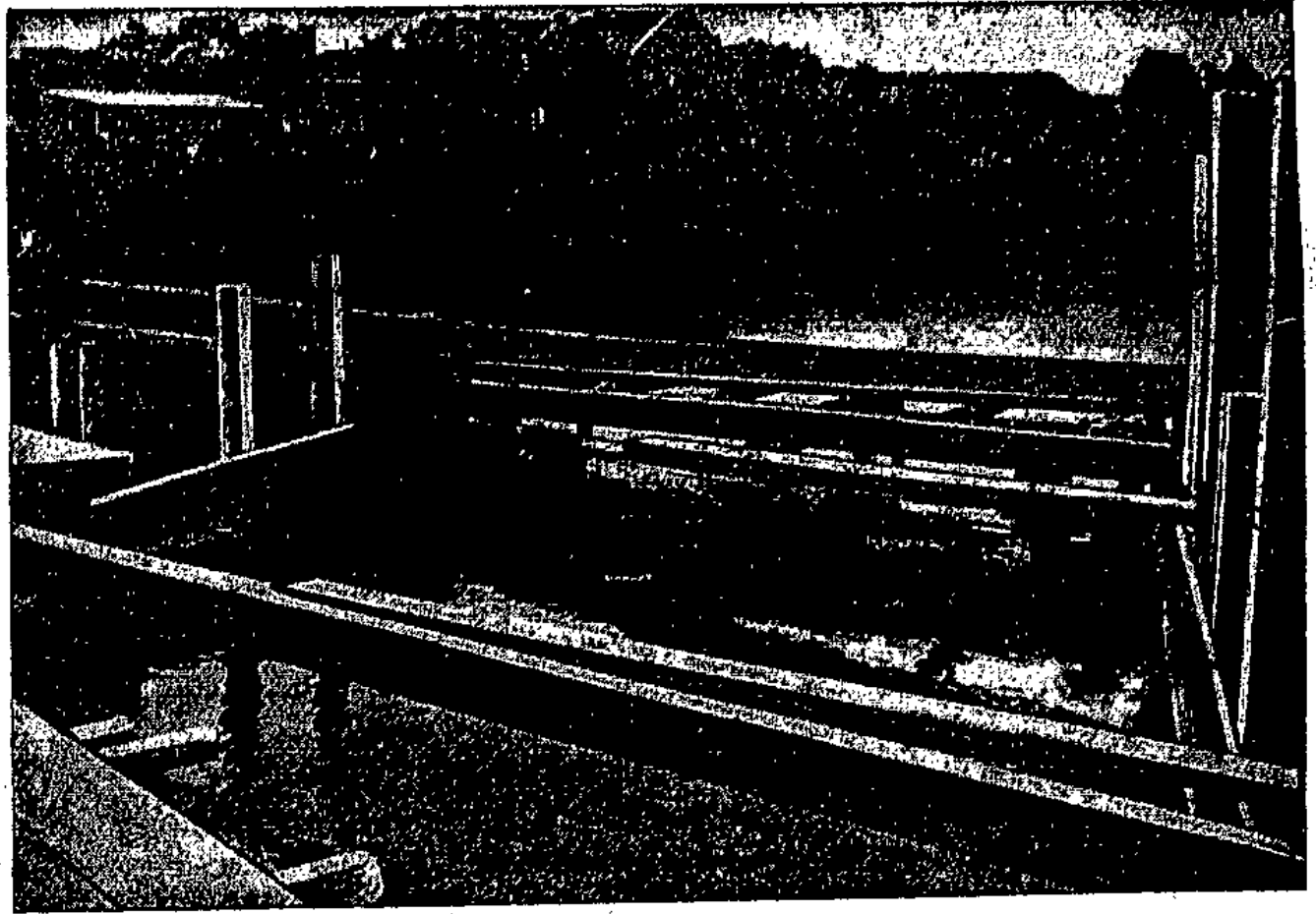
Blick in den Graben, der die Wasserrohre aufnehmen und unter die Ohre hindurchführen soll. Im Hintergrund quer das hölzerne Ueberleitungsbett des Mähdens.
