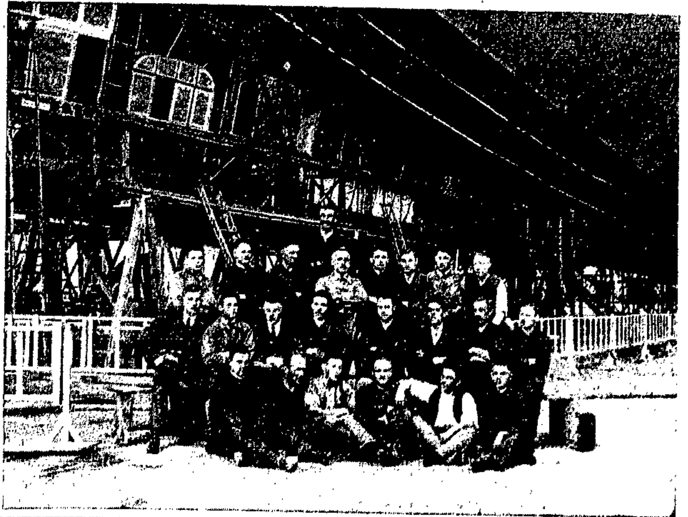
Das Luftschiff in Friedrichshafen. Ein Bild aus der Werkstatt mit den Monteuren
