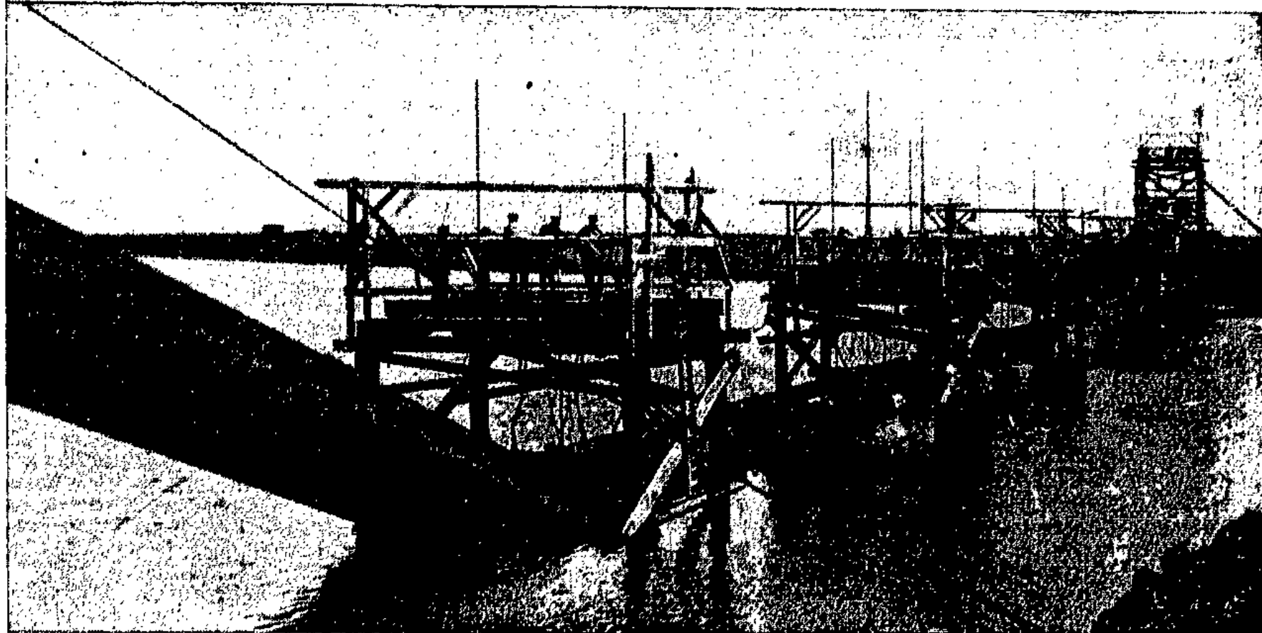
Wir berichteten in der Donnerstagsausgabe der „Volksstimme“ von dem großen technischen Werk, daß im neuen Industriegebiet bei Rothensee mit der Verfertigung eines Dükers in den Mittellandkanalhafen begonnen wurde. Unser Bild zeigt den Beginn der Arbeit. Die beiden Röhre liegen noch auf der Wasseroberfläche.
