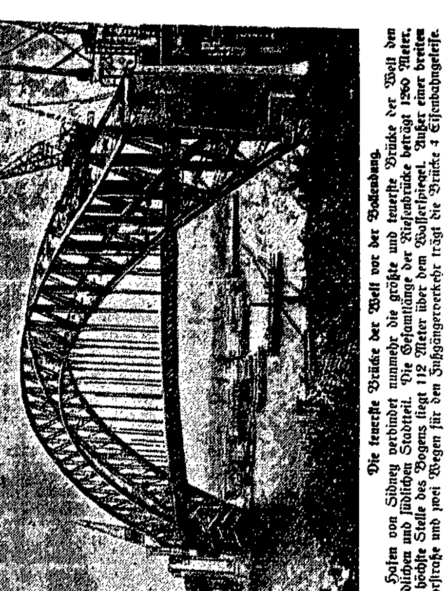
Die neueste Brücke der Welt vor der Bollung. Im Süden von Sydney verbindet nunmehr die größte und teuerste Brücke der Welt den nördlichen und südlichen Stadtteil. Die Gesamtlänge der Brücken beträgt 1260 Meter, die höchste Stelle des Bogens liegt 112 Meter über dem Wasserpiegel. Auf einer breiten Fahrstraße und zwei Wegen für den Fußgängerverkehr trägt die Brücke 4 Eisenbahngleise.
