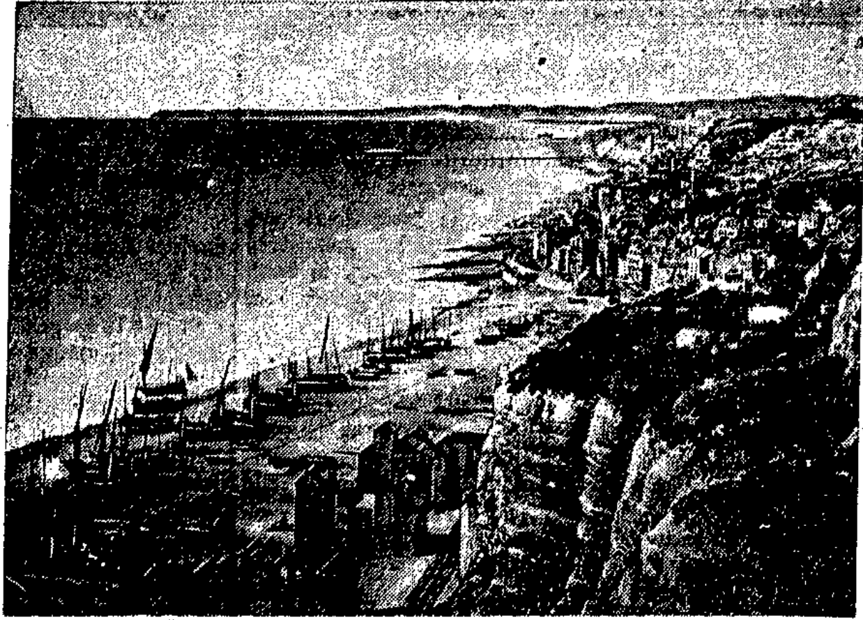
Das Städtchen Hastings bei Napier, das ebenfalls zerstört wurde.
