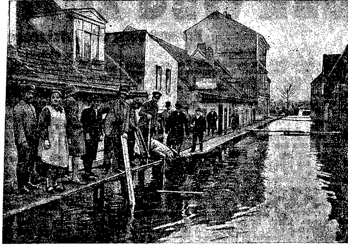
Baufstege werden befestigt, um die Land- und Dorfstraßen der Frankfurter Gegend gangbar zu machen.
