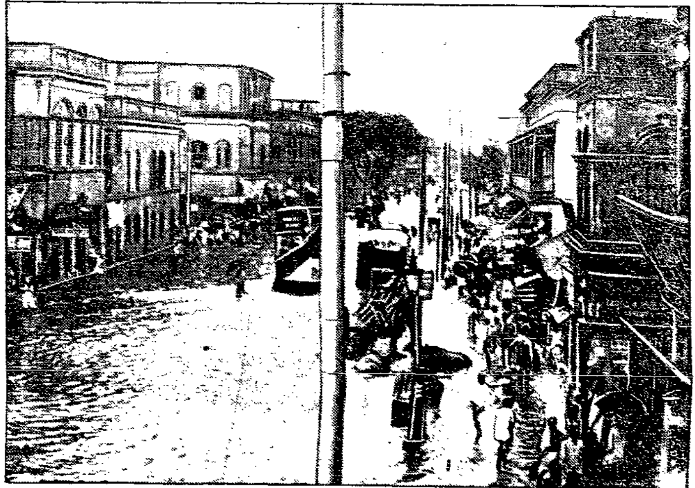
Ueberichwemmte Hauptstraße in Kalkutta.
