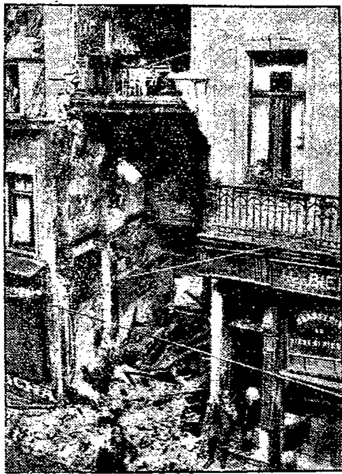
Durch eine Gasexplosion wurde der Flügel eines Brüsseler Wohnhauses fast gänzlich zerstört. Grundpfiler wurden umgelegt und der größte Teil der massiven Mauer wie Papier heraufgedrückt. 7 Personen wurden unter den Trümmern begraben.
