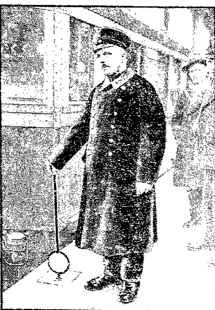
Der Bahndienstleiter ist mittels des Signalbells einen Kontakt aus, worauf aus den Lautsprechern der Ruf „Bitte zurückbleiben!“ ertönt.
