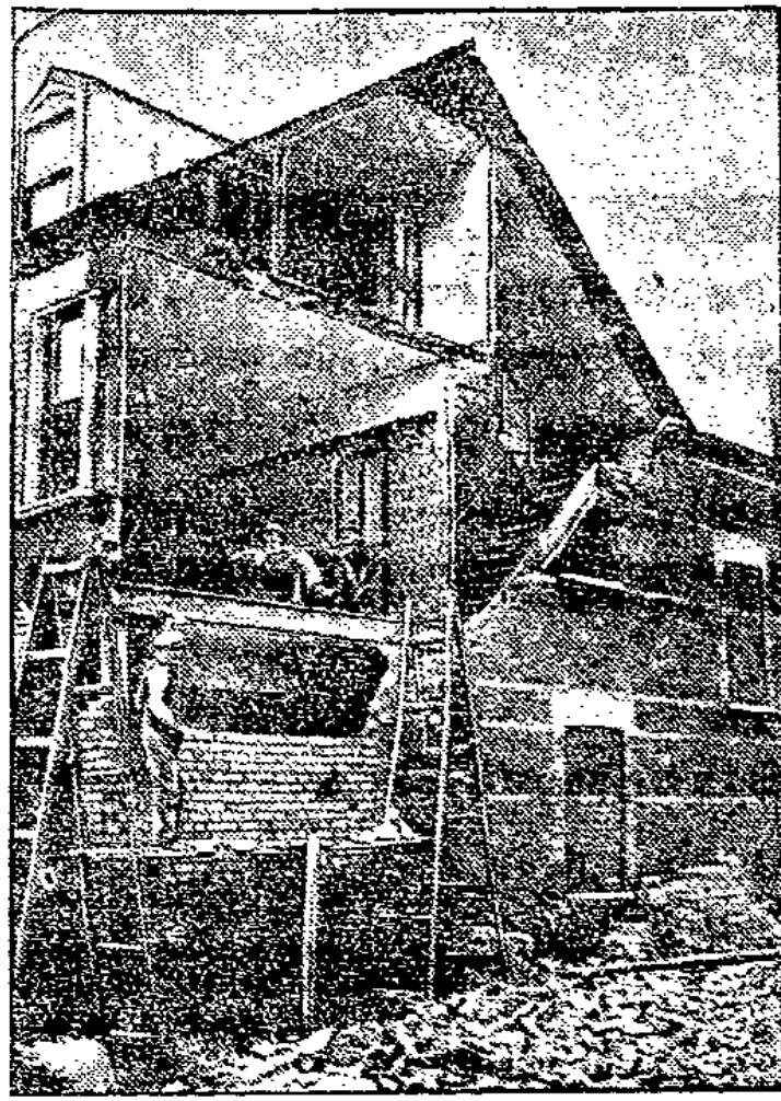
Ein Haus in London, dessen Giebelwand durch den Sturm umstürzte. Zwei Personen wurden durch die niederfallenden Trümmer getötet. Der Sturm, der die Nordseeküsten heimsuchte, hat besonders Südbengland schwer betroffen und neben großen Verheerungen zahlreiche Menschenleben gefordert.
