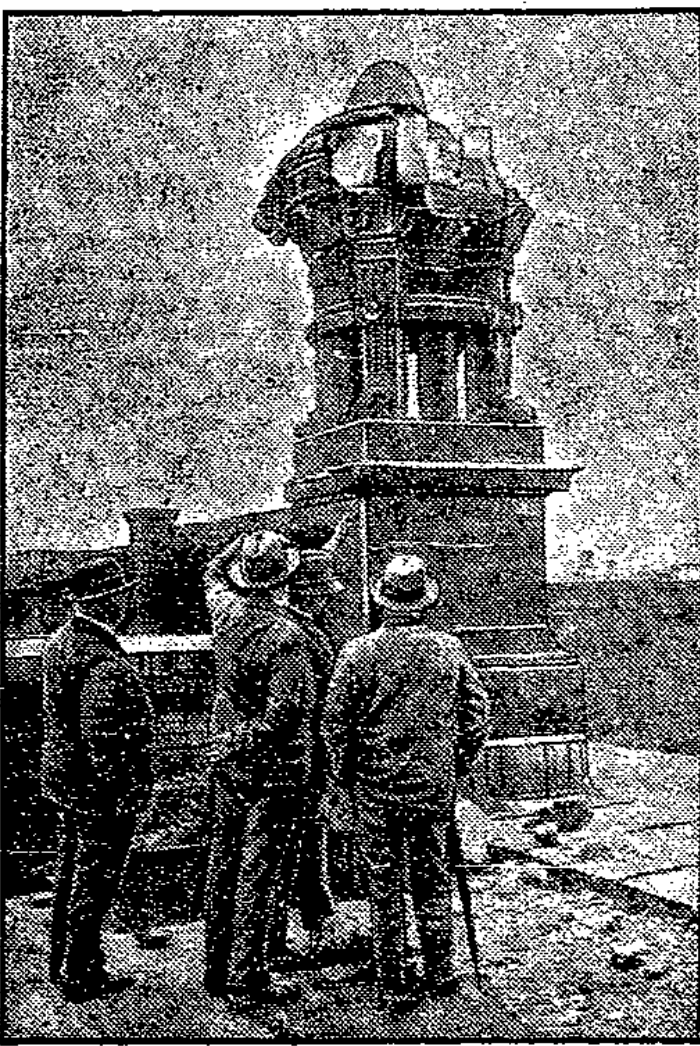
Zerstörung auf dem Dach des Gebäudes.
