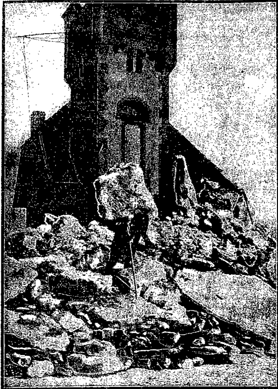
Eisangriff auf die Schöpfstelle des Wasserwerks bei Preßer.
