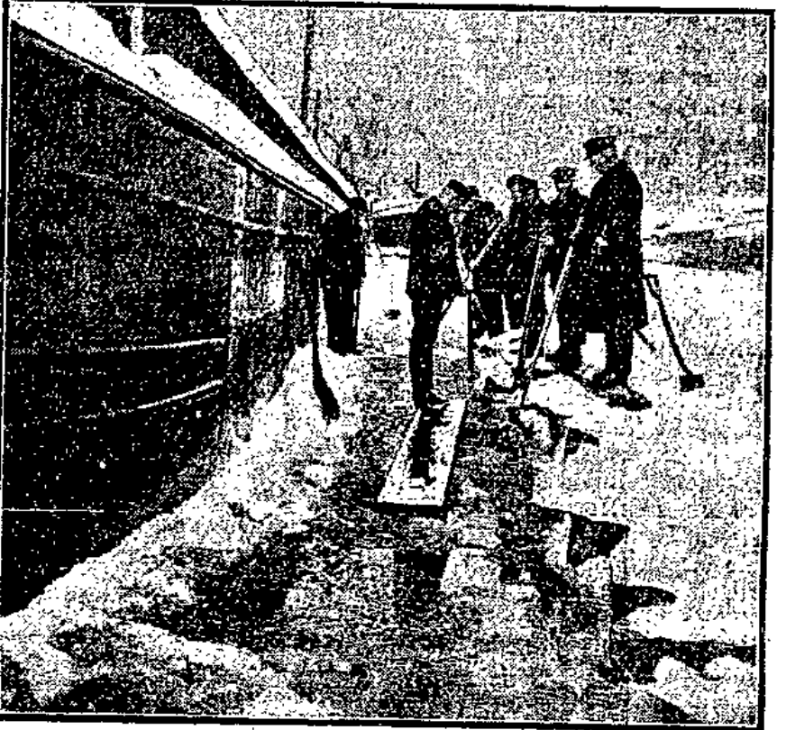
Die Kähne im Hafen müssen ringsum vom Eis gelöst werden, da sie sonst zerdrückt werden.
