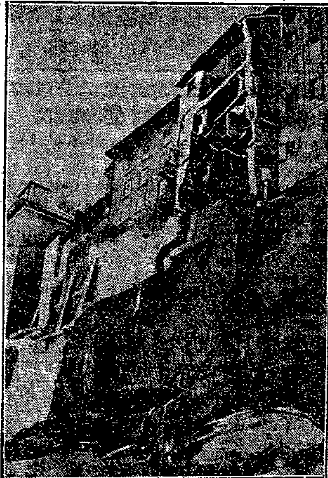
Im Zentrum der Stadt Freiburg (Säweiz) hat sich ein schwerer Felssturz ereignet. Mehr als 200 Kubikmeter Gesteinsmassen fielen in die Tiefe. Das Unglück hat einer Frau das Leben gekostet. Die Grundlagen und die Fassaden von mehreren Häusern wurden zerstört.
