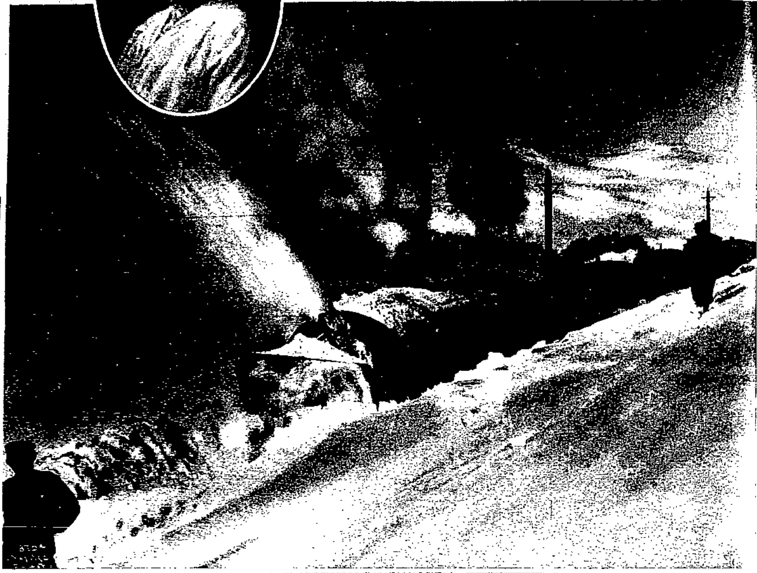
Rotierender Schneepflug säubert eine verschneite norwegische Bahnstrecke phot. Wilsø
