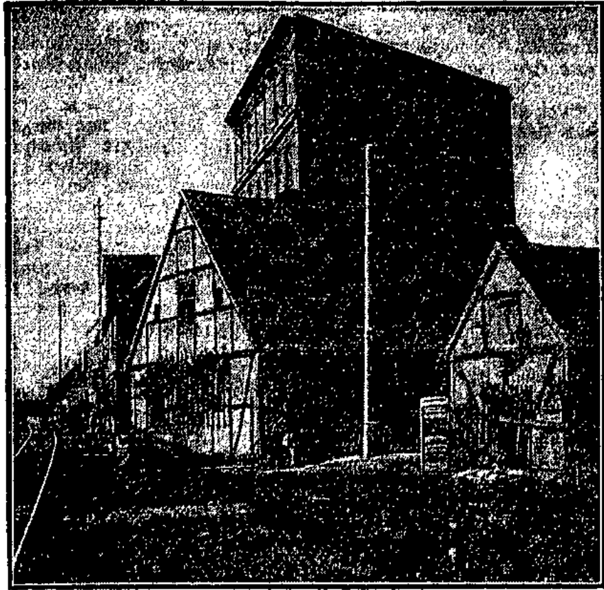
Haus Genthiner Straße 27, das der neuen Straßenbahn im Wege stand.
