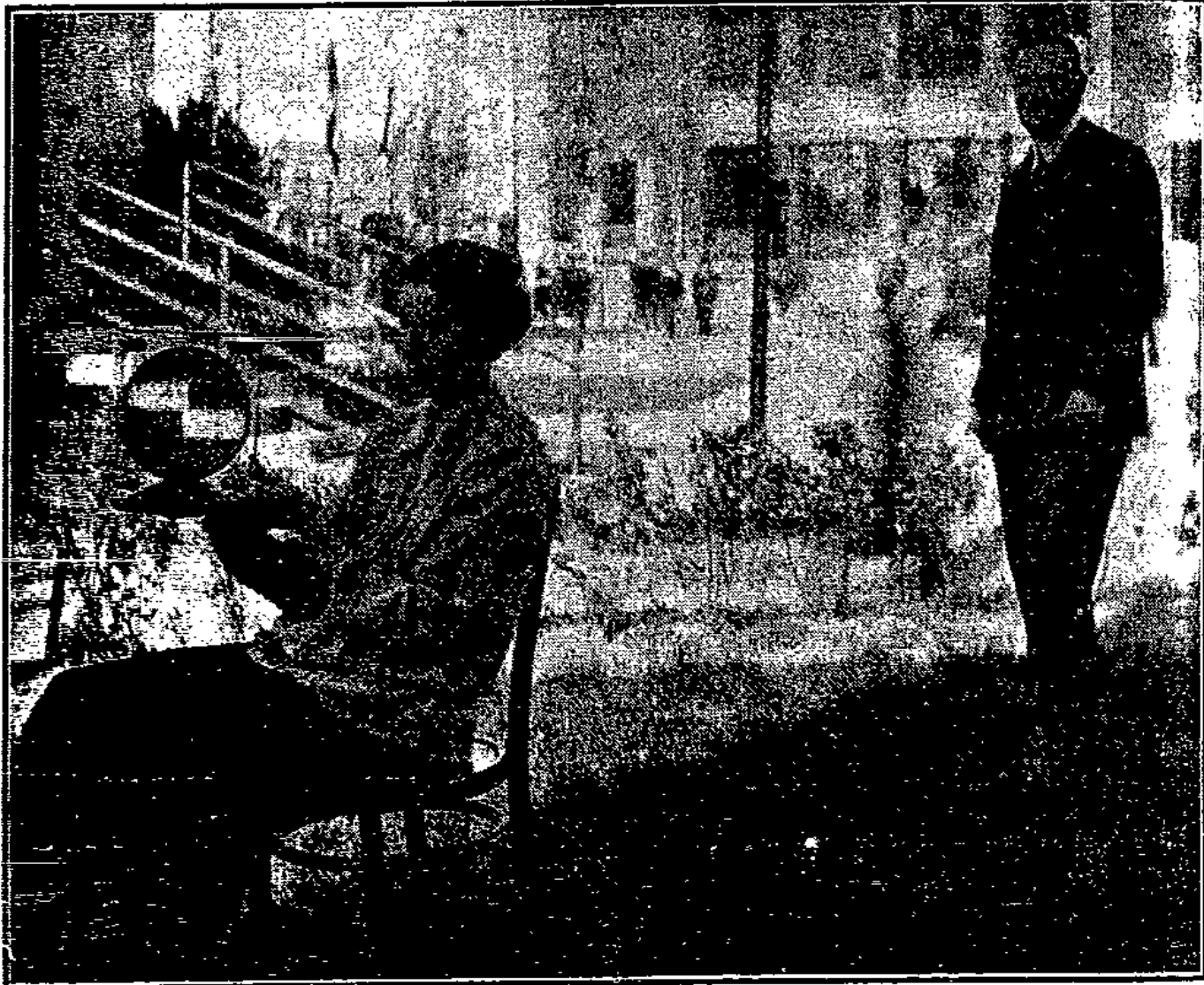
Durchsichtiges Metall. Die Frau im Bilde hält eine in einen Rahmen gespannte Goldplatte die so dünn ist, daß man hindurchsehen kann (1/20 Millimeter), man erkennt bei dieser Momentaufnahme klar die Stufen der Treppe im Hintergrund. Rechts im Bilde der Erfinder dieses technischen Wunders, Dr. Müller (Berlin).
