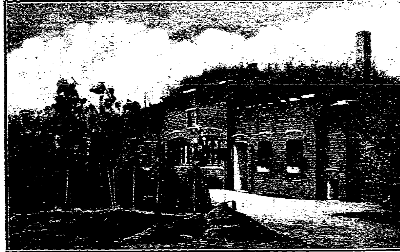
Die Kasematte ist Schulhaus geworden.
