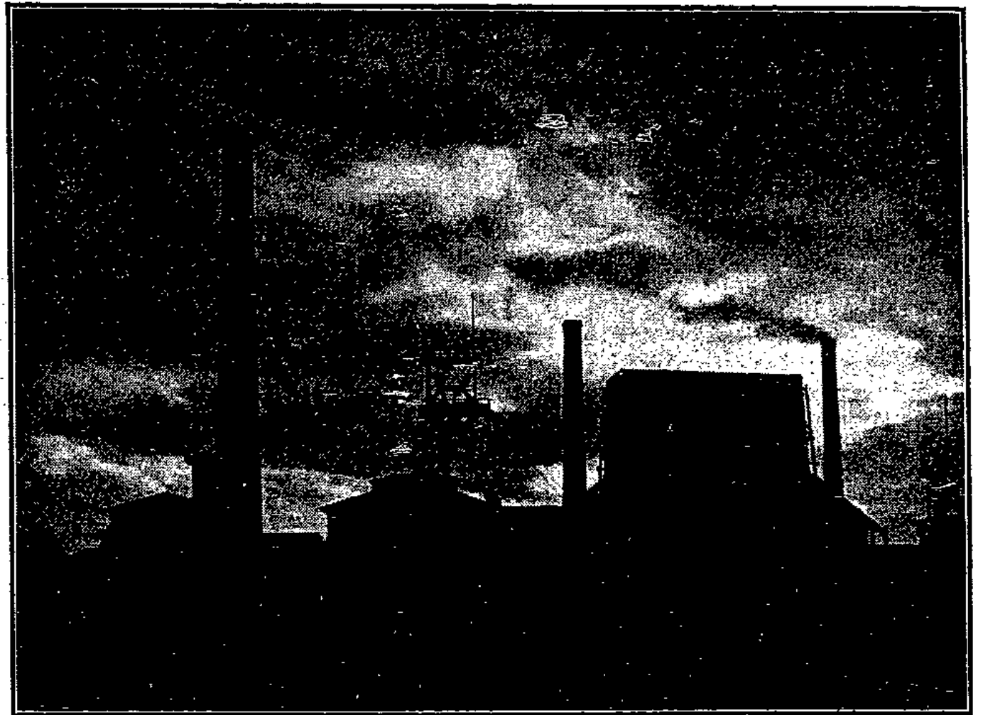
Schachtanlage in der Nacht.
