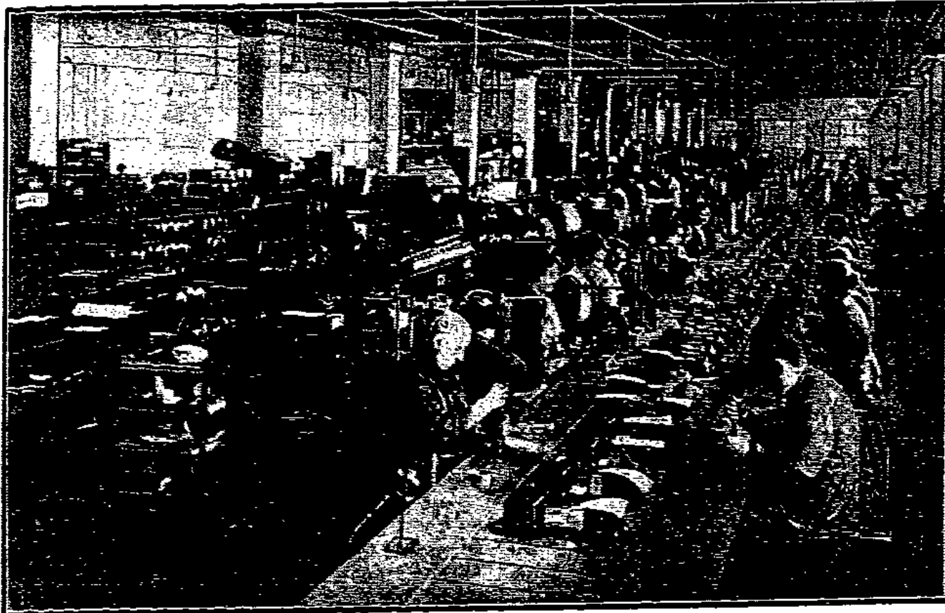
Fließarbeit. Unser Bild zeigt die Arbeiter in der A. E. S. in Berlin, wie sie am fließenden Bande Stromfahler montieren. Die A. E. S. hat auf dem fließenden Band bereits 8 Millionen Fahler hergestellt lassen. Das Werk, die Technik haben ihren Erfolg, viele Arbeiter aber finden in der „rationalisierten“ Industrie kein Unterkommen mehr. Sie sind dem Elend der Erwerbslosigkeit preisgegeben, bis Produktionsmöglichkeit, Verteilung und Organisation der Arbeit in Einklang gebracht werden.
