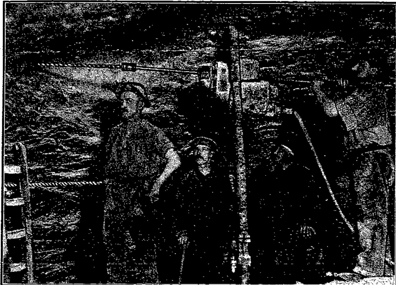
Elektrische Bohrmaschine im Salzbergwerk.
