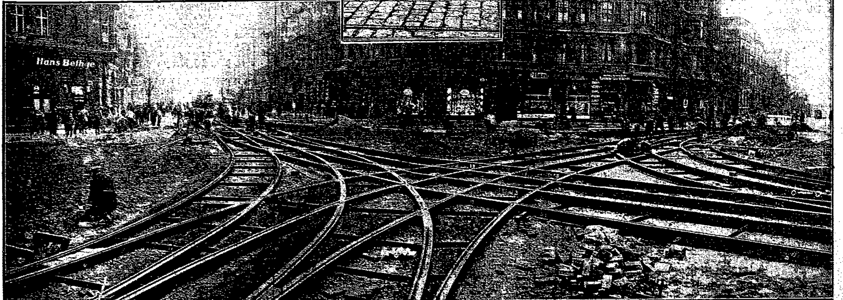
Beispiele von Straßenarbeiten: Gleisverlegung am Gassebachplatz; oben: Bergreifen der Fugen mit Engspalt
