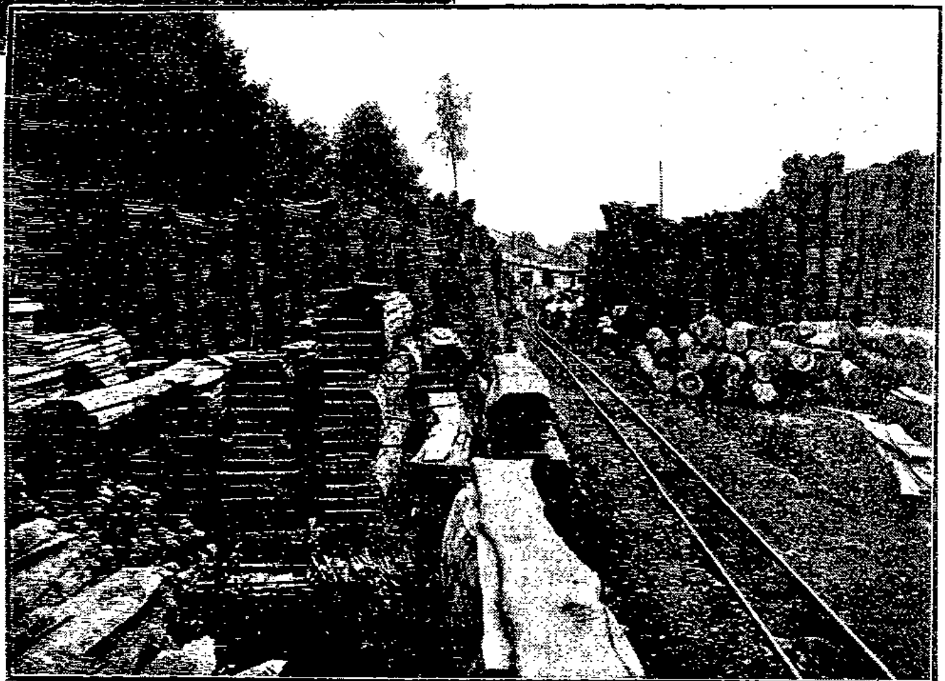
Laubholzjägewerk Scheile & Co. in Rottleberode. Das Holzlager ist 1 Kilometer lang.
