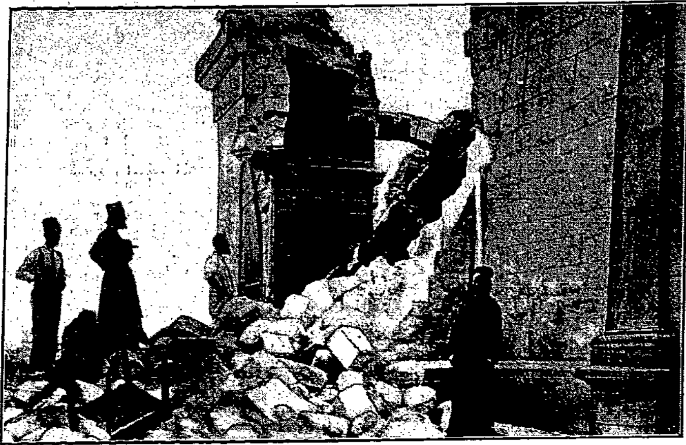
Das Erdbeben in Palästina. Die griechische orthodoxe Kirche von St. John, in der Nähe des Jordans, wurde in einen Trümmerhaufen verwandelt.
