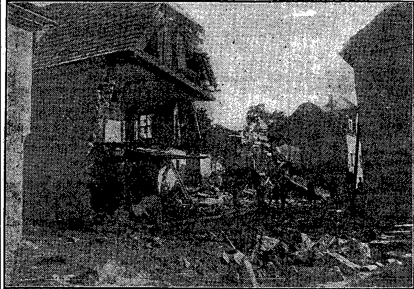
Vom Wasser eingerissene Hauswand.
