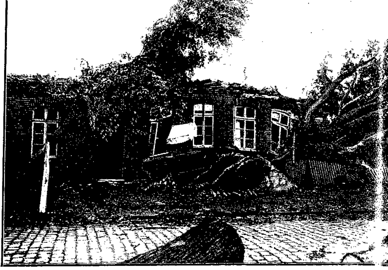
Die Wirbelsturmkatastrophe im Emsgebiet. Große alte Bäume, die wie Streichhölzer umgeknickt wurden und deren Wurzeln die Fundamente des Hauses in die Höhe hoben.
