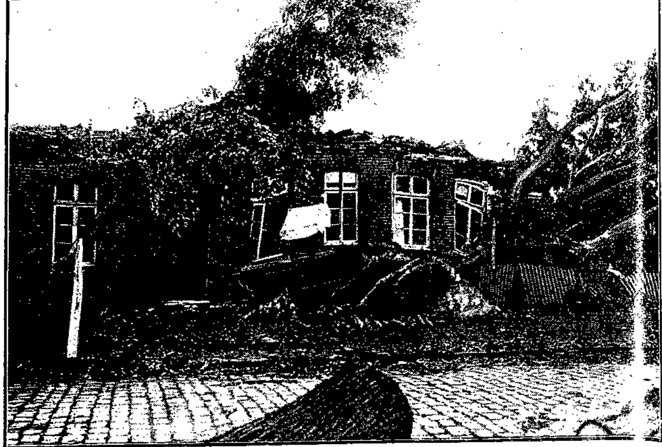
Die Wirbelsturmkatastrophe im Emsgebiet. Große alte Bäume, die wie Streichhölzer umgeknickt wurden und deren Wurzeln die Fundamente des Hauses in die Höhe hoben.
