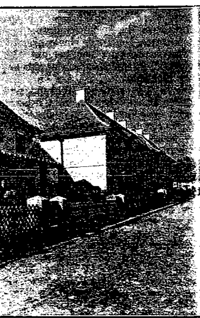
Wiener Siedlung im Flachbau.
