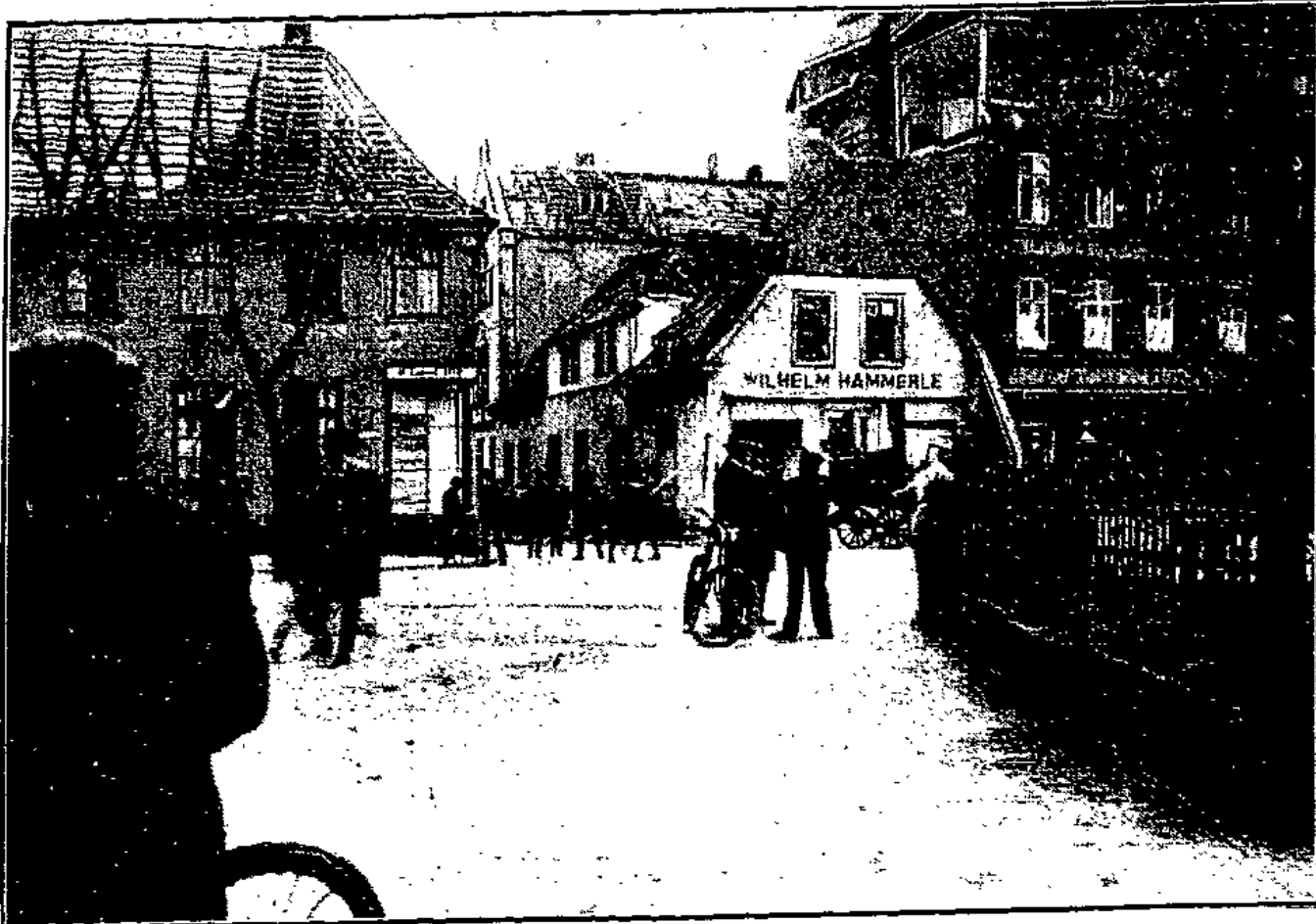
Die Wirbelsturmkatastrophe im Emsgebiet. Beschädigte Häuser der Stadt Eingen.
