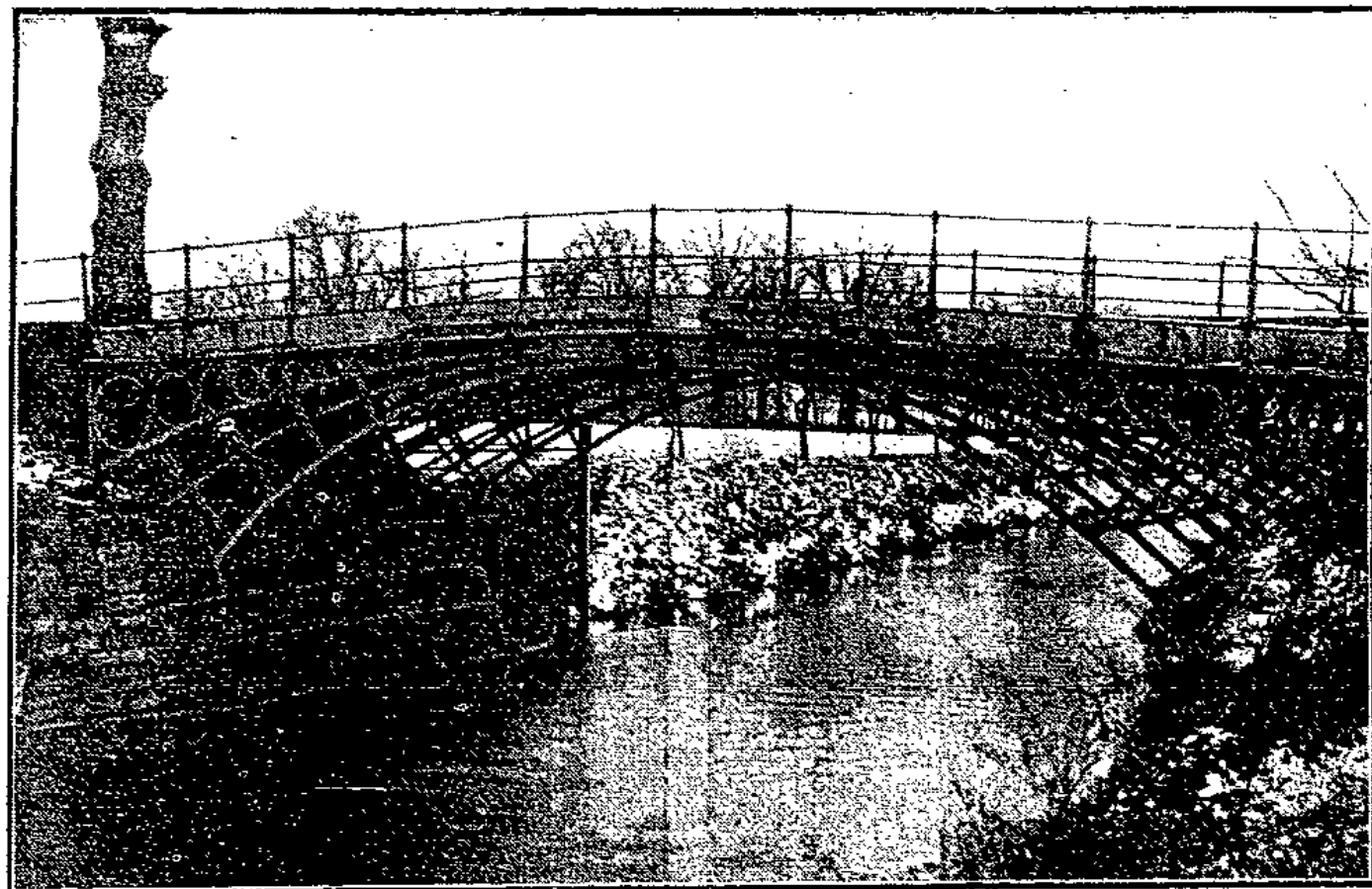
Die älteste Eisenbrücke Europas in Einsturzgefahr. Die 1796 erbaute Brücke über das Striegauer Wasser in Lassa (Kreis Striegau) droht einzustürzen.
