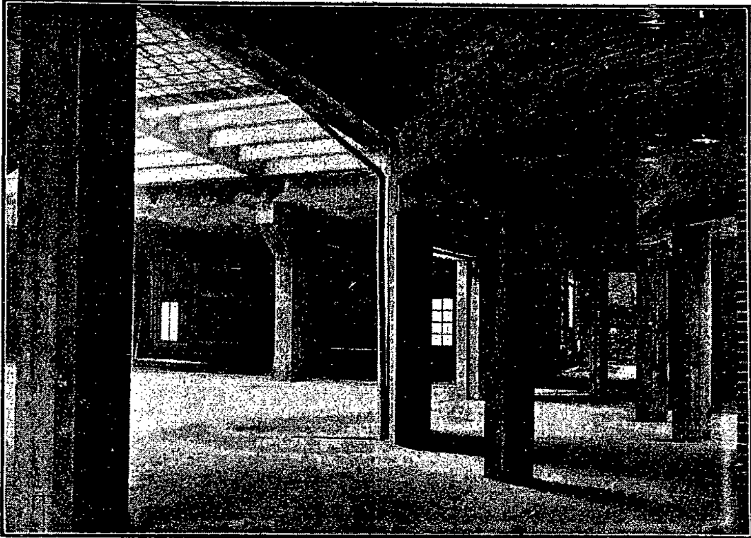
Bild 12. Windfänge vor der großen Schalterhalle
