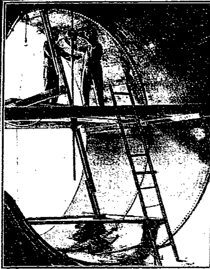
Bohren der Rietlöcher im Spiralgehäuse der 40000-P.S.-Turbine. Die Maschinenfabrik von J. M. Voith in Heidenheim (Württemberg) baut diese Anlage.
