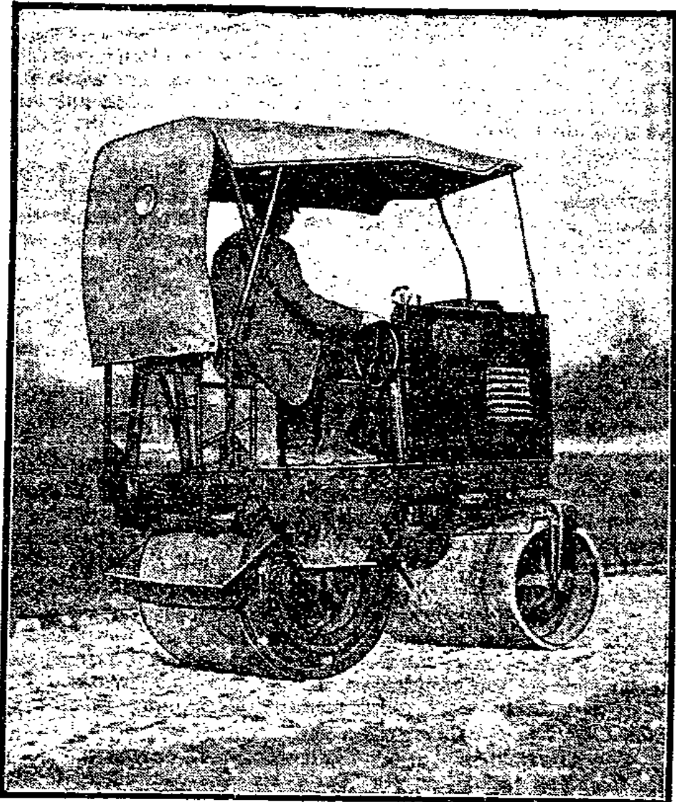
Festwalzen der planierten Platzanlage.
