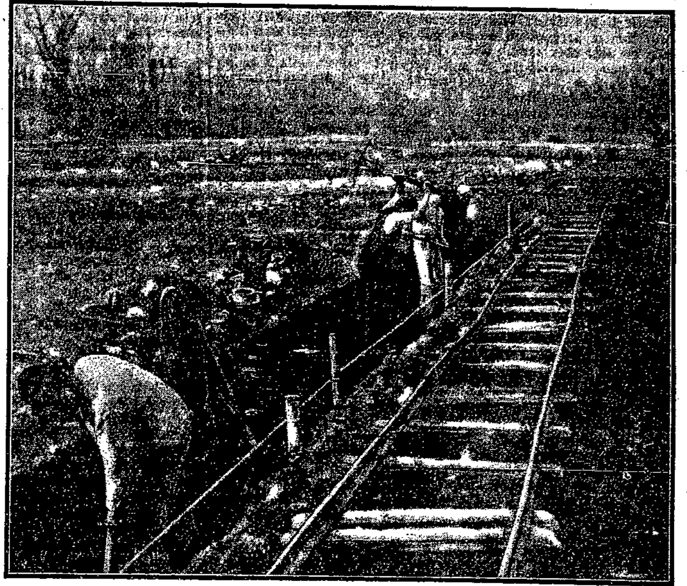
Die Arbeiten auf der Seilerwiese.
