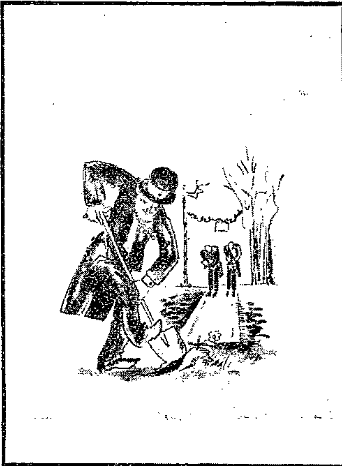
Der erste Spatenstich zum neuen Rathaus.
