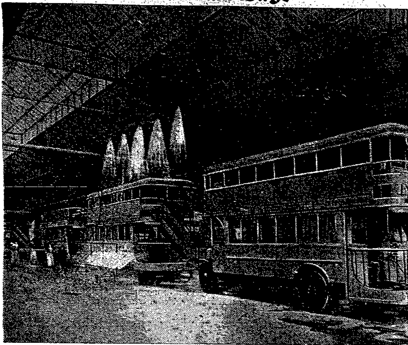
Das neue Riesenautobus-Hotel in Berlin Die Allgemeine Berliner Omnibus-Aktiengesellschaft hat einen neuen Betriebshof eingeweiht. 200 Omnibusse finden hier nach anstrengender Tagesarbeit ihre Nachtruhe. Baukosten 1 1/2 Millionen RM.
