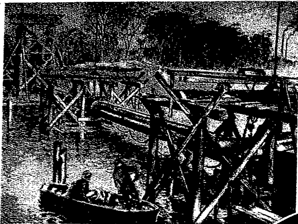
Verlegung einer Gasleitung zum Durchqueren eines Schiffahrtskanals
