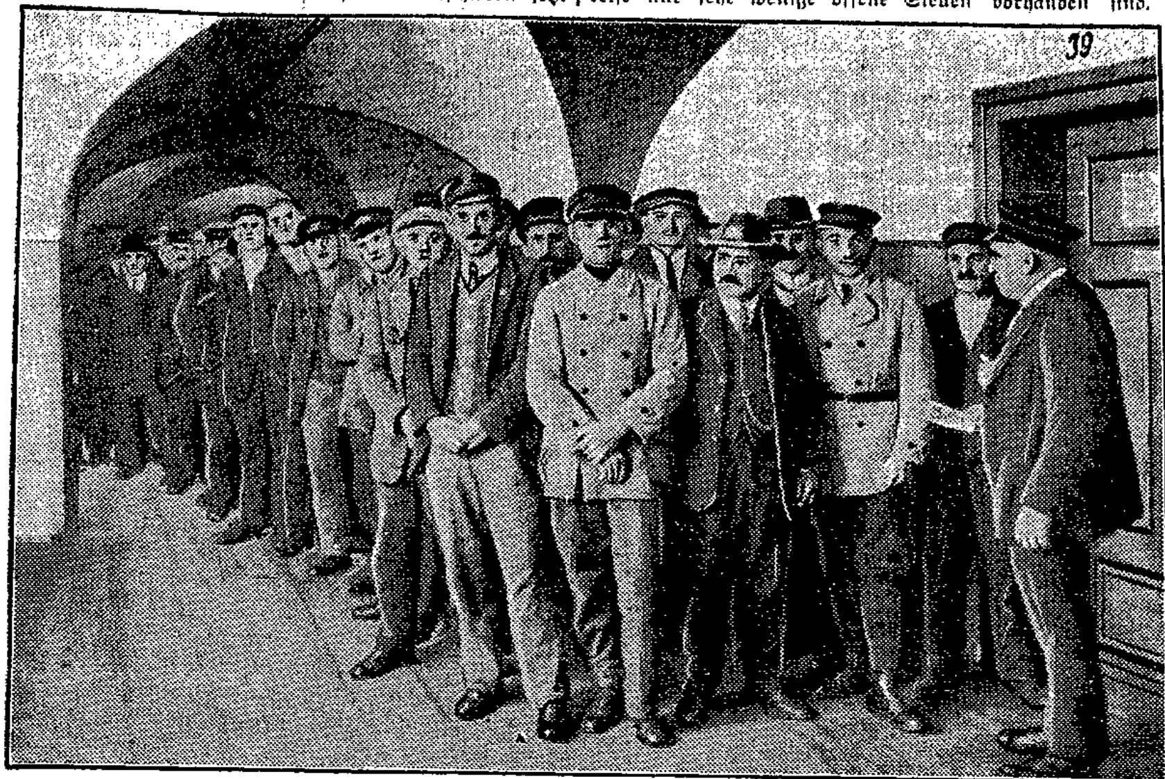
Vorraum zum Kassenraum.
