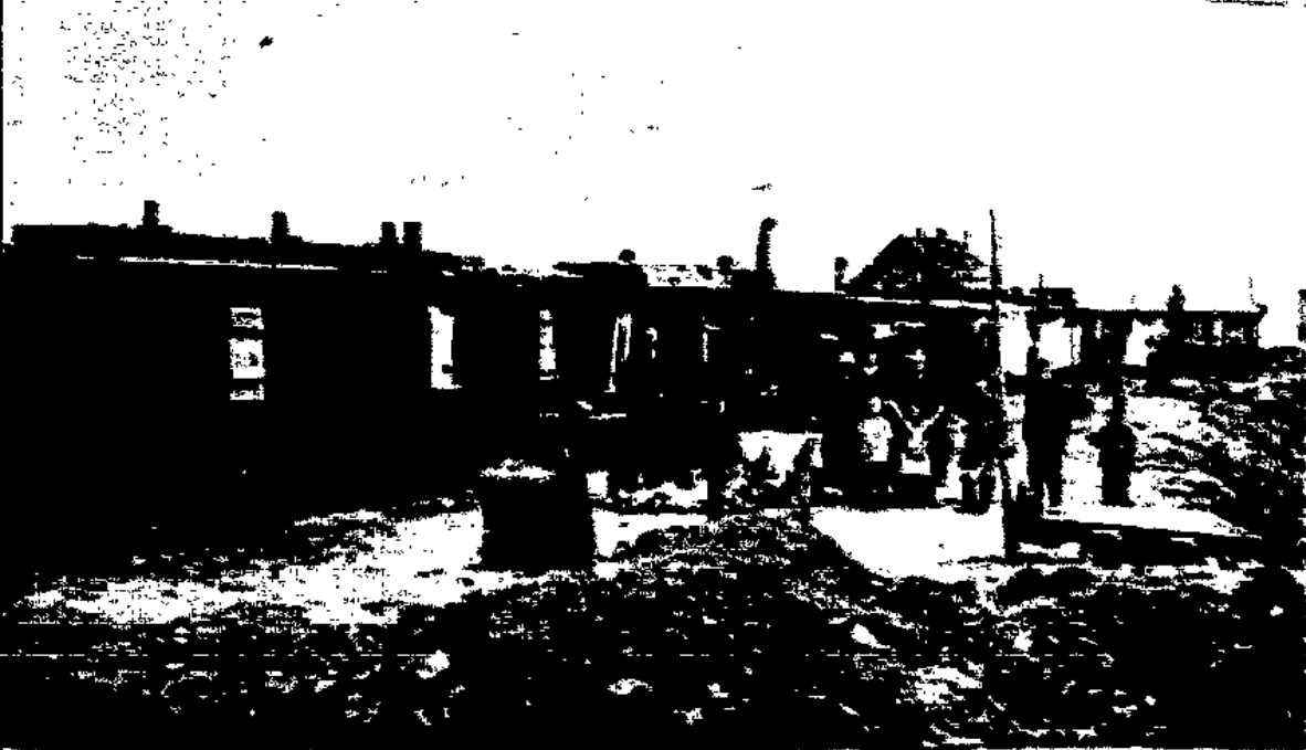
Eisenhüttenwerk-Gebäude in Witten (Westphalen); bis jetzt hausen 10 Familien inmitten der Schmelzen einer früheren Kohlenzeche
