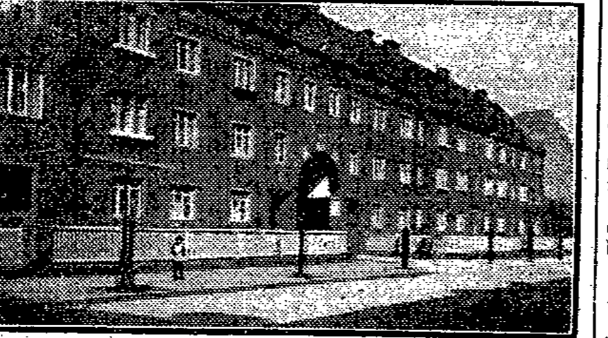
Eingang zum Westernplan in der Klopstockstraße.
