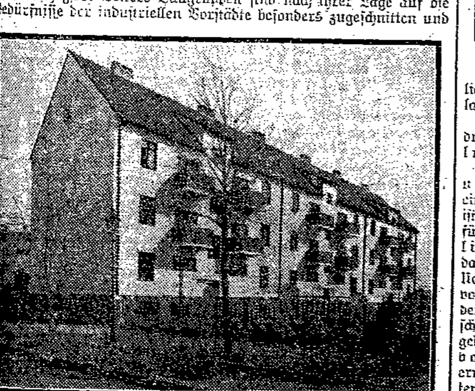
Eingelassene Ansicht eines Hauses in der Braunschweiger Straße. (Mietbau- und Sparverein.)
