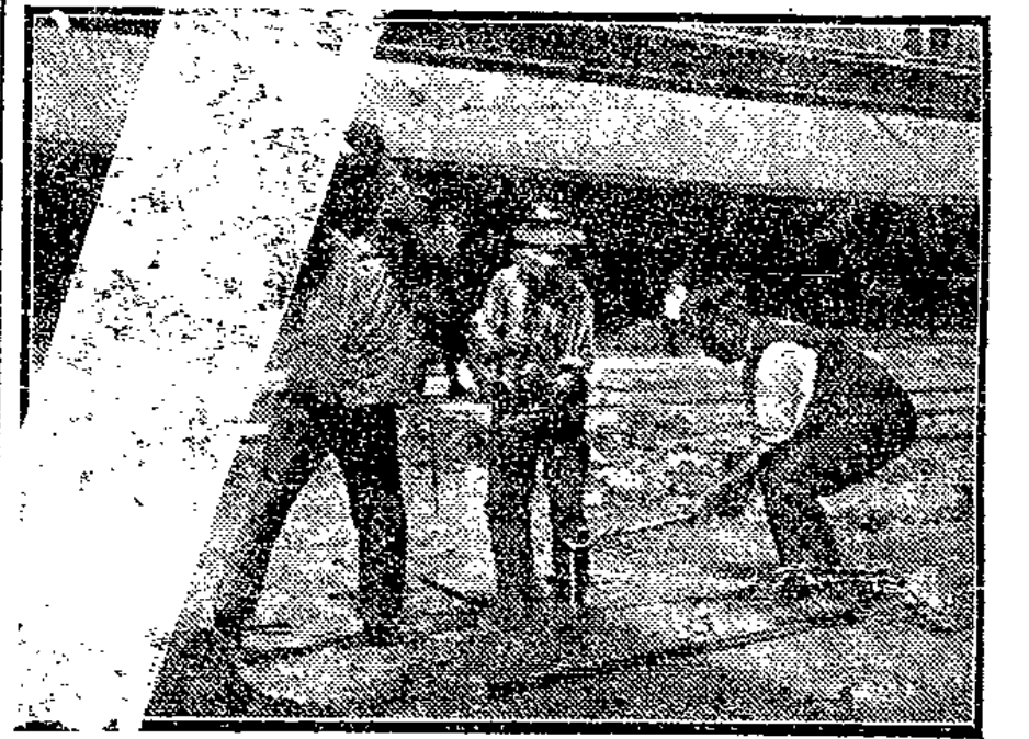
Aufbrechen der alten Betondecke.
