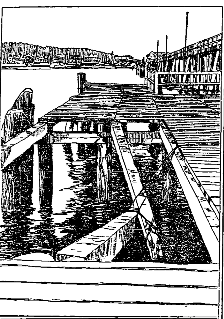
Die Brückstelle in der Binger Landungsbrücke.
