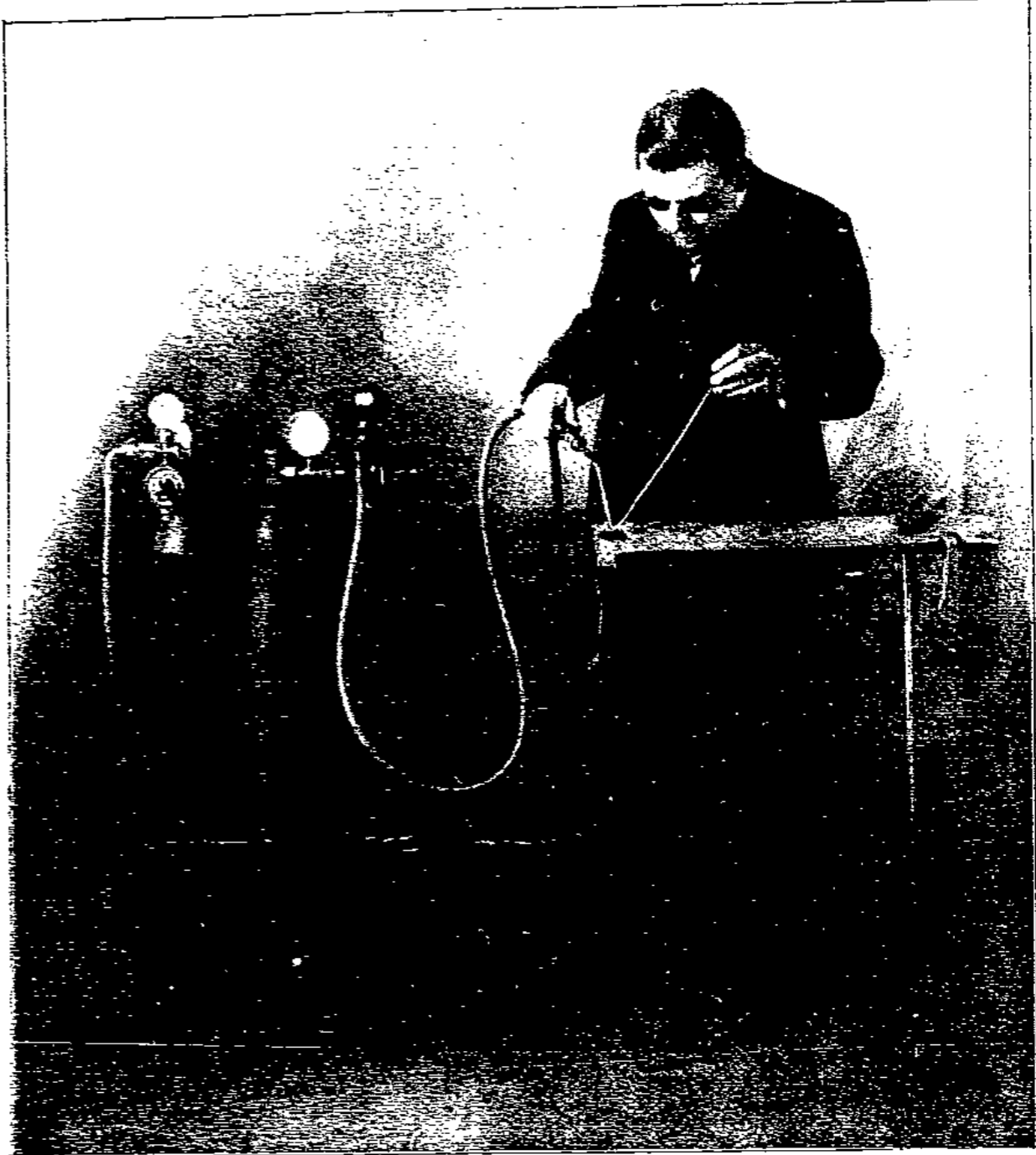
Apparatur für autogene Schweißung im Betrieb: Anschweißen eines geschmiedeten Bügels an eine Eisenplatte mittels Wasserstoff-Sauerstoff-Gebläseflamme.
