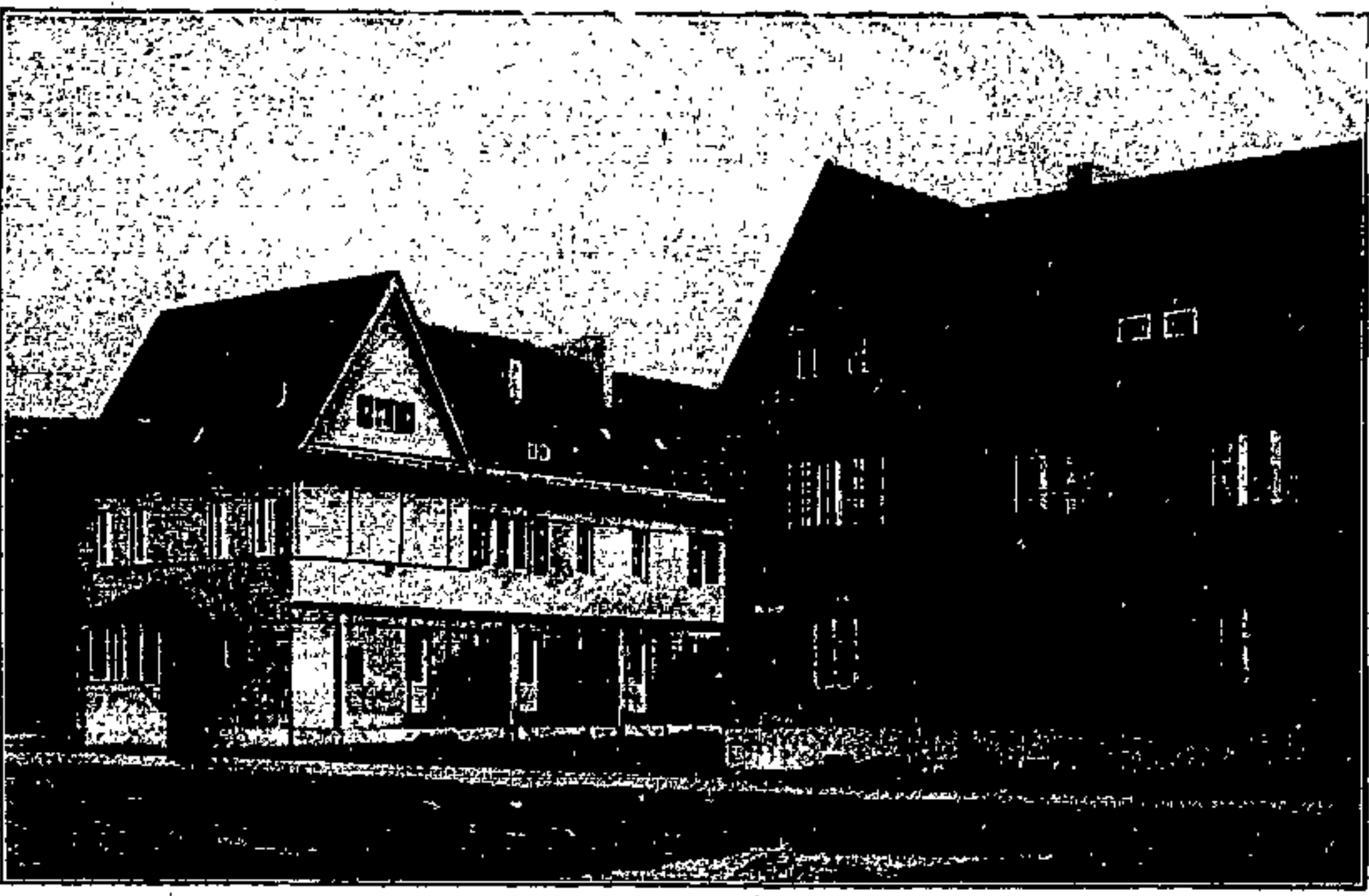
Bild auf die Hinter-(Garten-)front eines Kleinhauses.
