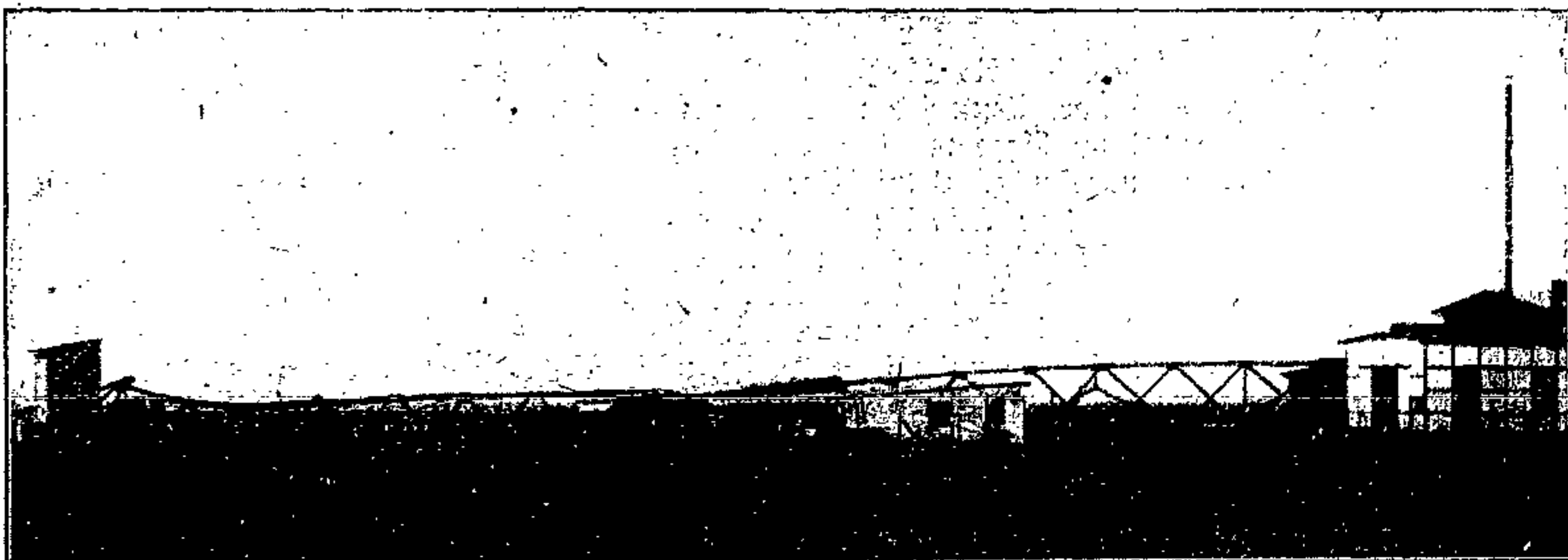
Der 200 Meter hohe Turm der Raucener Telefontastation nach dem Einsturz. Der am 30. März d. J. infolge eines heftigen Sturmes zusammengebrochene Turm ermöglichte die Entsendung drahtloser Telegramme auf eine Entfernung von über 5000 Kilometern.
