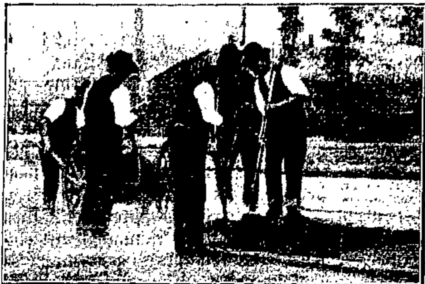
Die Asphaltmasse wird aufgetragen.
