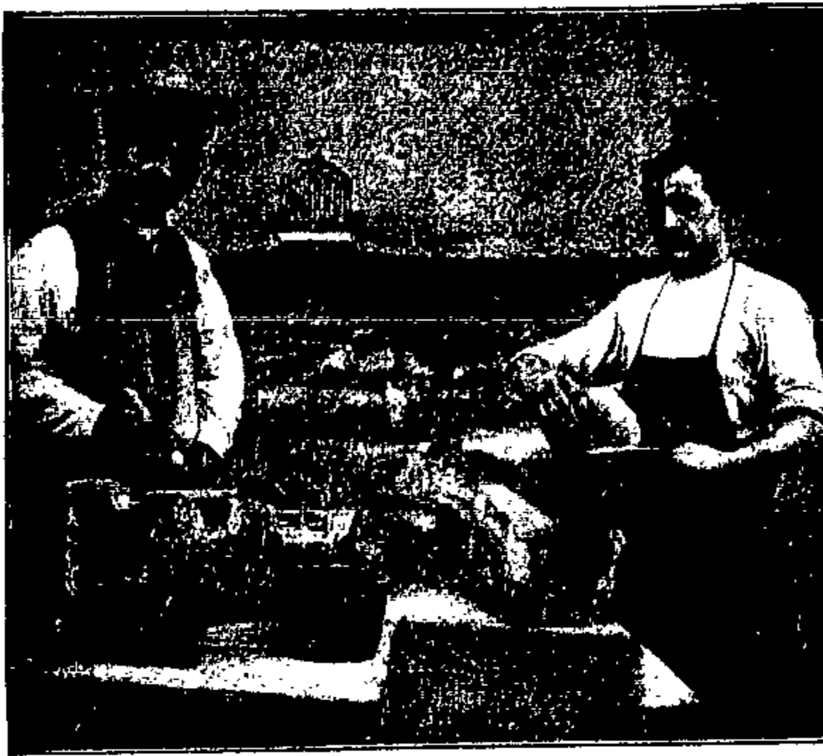
Graue Pappe, das Material für die feineren Puppen, wird feucht in die Form gepreßt.
