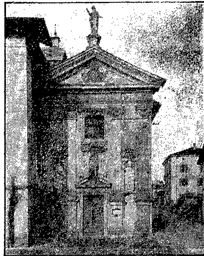
Die Sankt-Rochus-Kirche, ein prachtvoller Barockbau in Biffone am Luganer See.
