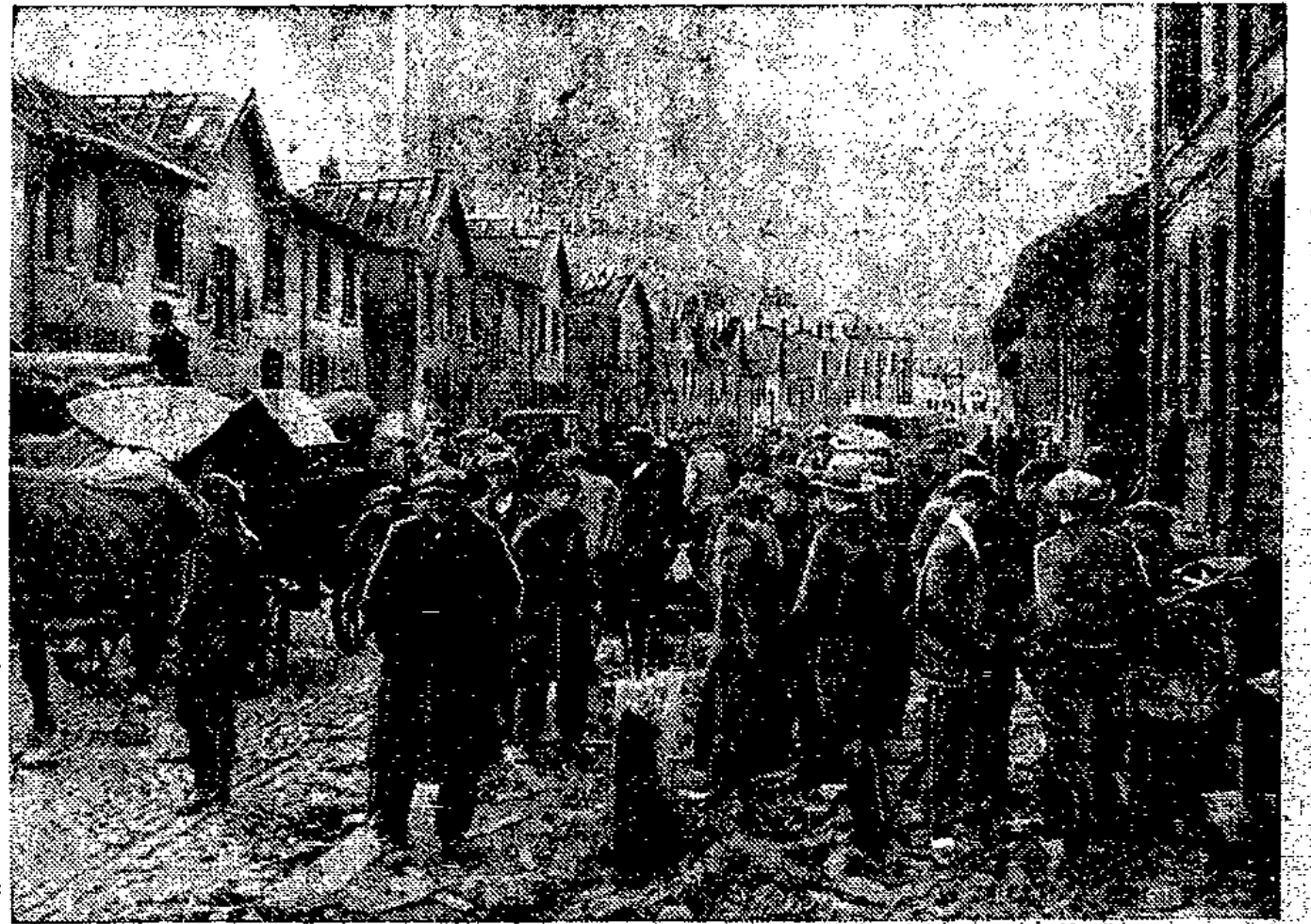
Eine Straße der Unglücksstadt Neunkirchen: durch den gewaltigen Luftdruck sind hier sämtliche Dächer abgedeckt worden.
