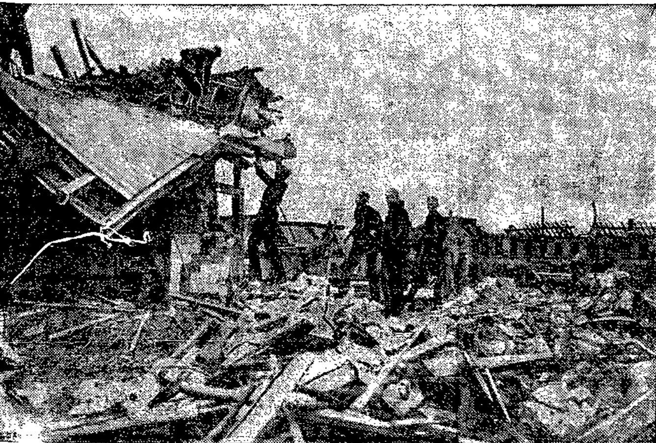
Feuerwehrlente suchen nach Toten und mit Verletzten, die unter den Schuttmassen begraben liegen.
