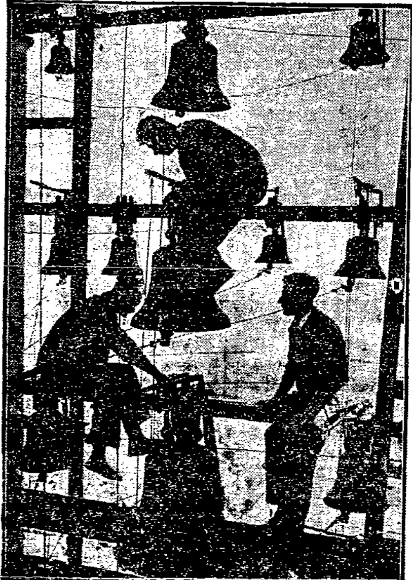
Das Potsdamer Glockenspiel wird ausgebeffert während der Ausbesserungsarbeiten an dem Glockenspiel der Potsdamer Garnisonkirche.
