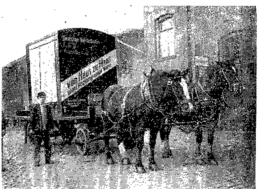
Großbehälter für die Möbelbeförderung mit Innenpolsterung, Decken und Gurten zum Verpacken von Möbeln. (J. A. Hüfner & Söhne, Limburg-Lahn). Der Behälter besitzt eine besondere Hubrollenvorrichtung, durch die er leicht vom Rollwagen auf den Waggon und umgekehrt verschoben werden kann.
