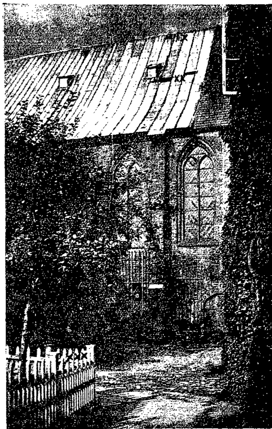
Der Sturz des Turmdachdeckers Rupperti vom Dach des Kirchenschiffes des Heilig-Geist-Hospitals
