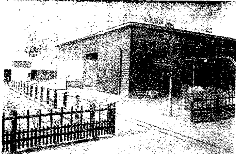
60-Morgen-Stelle; Wohnung, Stall und Scheune in einem nahezu quadratischen Baukörper vereinigt.
