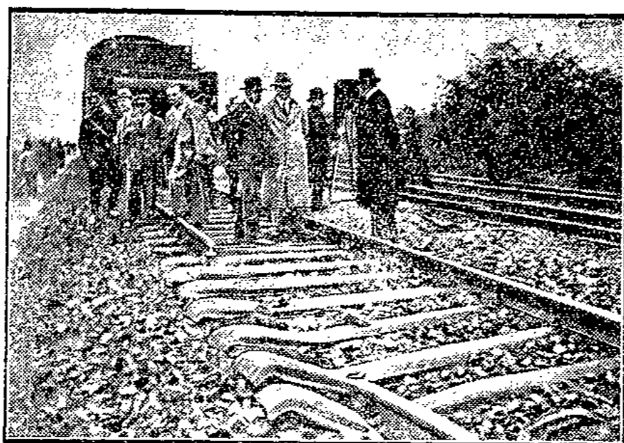
Links: ein Bild von der furchtbaren Wirkung des Anschlages, der auf den FD-Zug Basel-Berlin bei Bitterbog verübt wurde. Oben: hier wurde die Bombe zur Explosion gebracht — drei Meter Schiene wurden herausgerissen. So kam der Zug zur Entgleisung.
