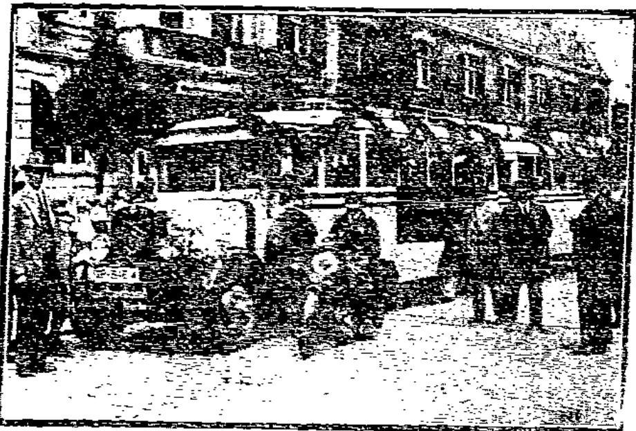
Die Epise des Korros bei St. Johannis
