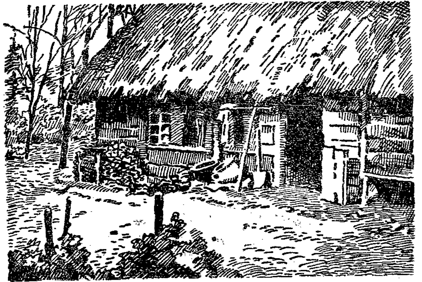
So wohnen seine Arbeiter
