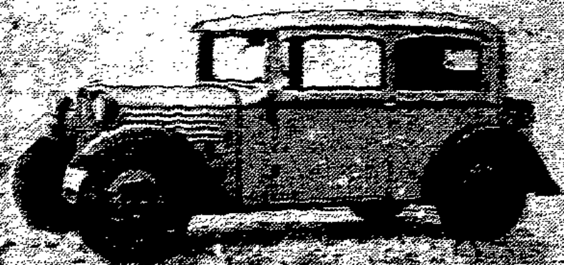
Der „Kleinwagen“ mit Vorderradtrieb und Schwingachsen, 12 Liter, 3 PS.
