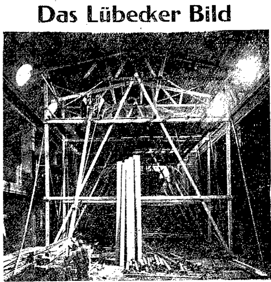
Der Saal des Gewerkschaftshauses
